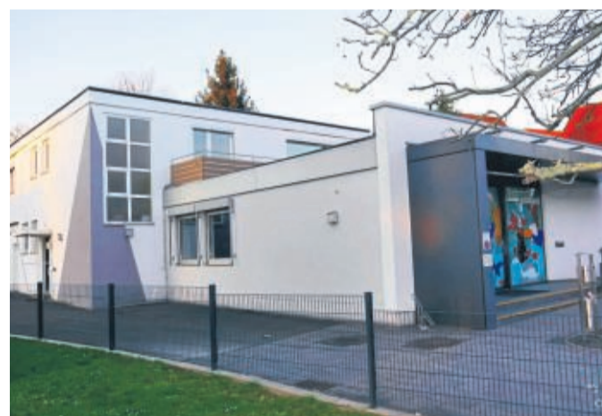
Ehemalige Bank: In der früheren Filiale soll ein Treffpunkt für ältere Menschen entstehen, in die Wohnung darüber ist das Büro von Jumpers und Sempers eingezogen.
